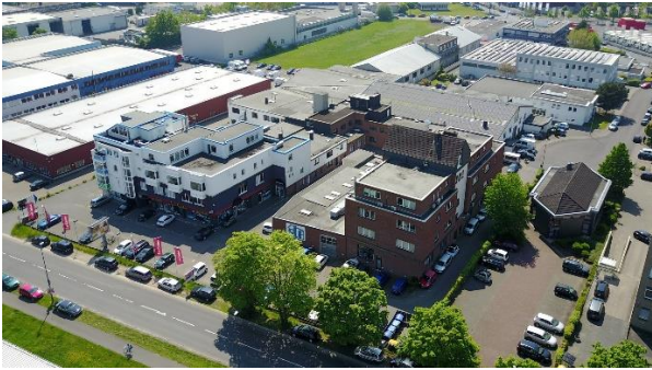
Köln Rodenkirchen – Gewerbepark „Erkerhof“
