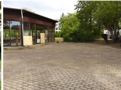
Entkernter Pavillon-Rohbau mit Parkplatz von Fichtestraße aus 2022
