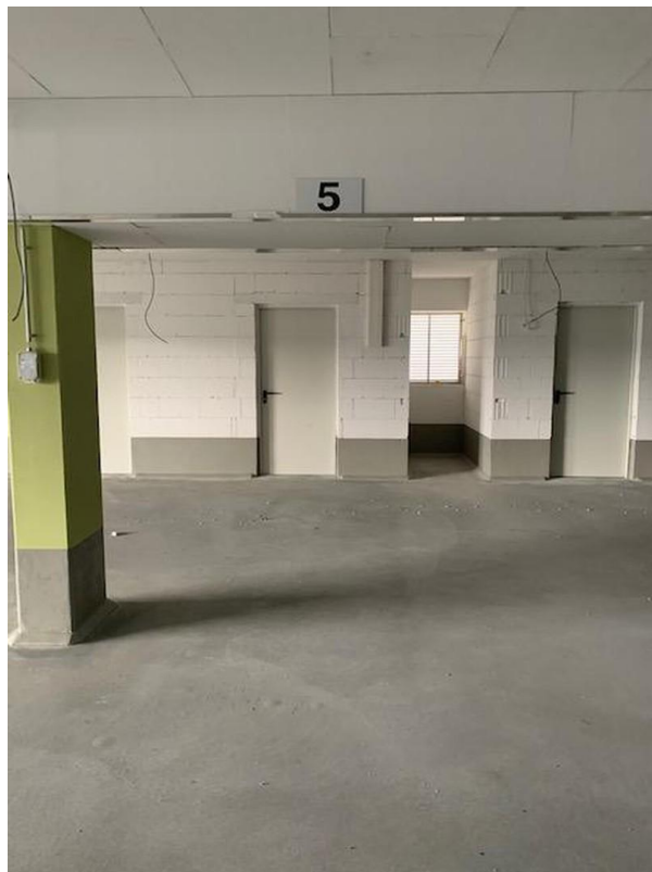
Tiefgaragenplatz mit Keller
