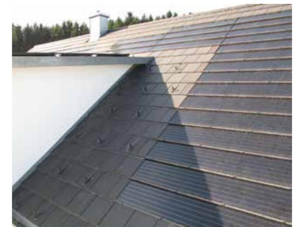
Mit unseren dachintegrierten Solarsystemen gehen wir sogar noch weiter. Wärme und Strom vom eigenen Dach gelten als besonders zukunftsfähig. Wir bieten abgestimmte, dachintegrierte Solaranlagen, die anstelle von Dachziegel oder Dachsteinen als vollwertige Bedachung in die Dachfläche integriert werden. So entsteht nicht nur ein harmonisches Deckbild, sondern auch ein funktionssicheres Dach.
