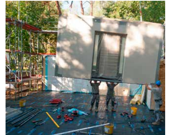
... auf LKW zum Bauplatz transportiert...
