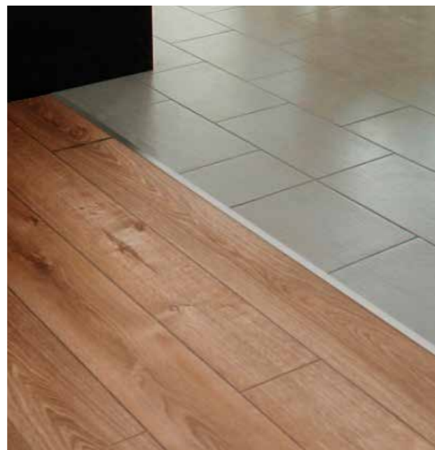
Übergänge zwischen zwei verschiedenen Bodenbelägen werden mit einer Fußbodenleiste kaschiert.
