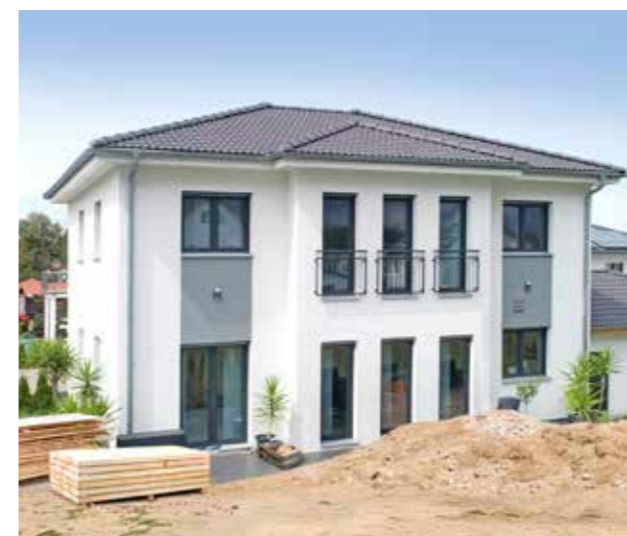
Nach ca. 12 Wochen ist die Villa fertig...
