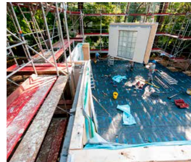
...und das Erdgeschoss auf das Fundament montiert.
