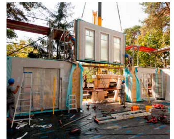
Anschließend wird das Obergeschoss aufgesetzt.
