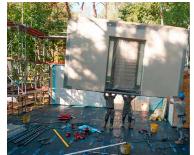
... auf LKW zum Bauplatz transportiert...
