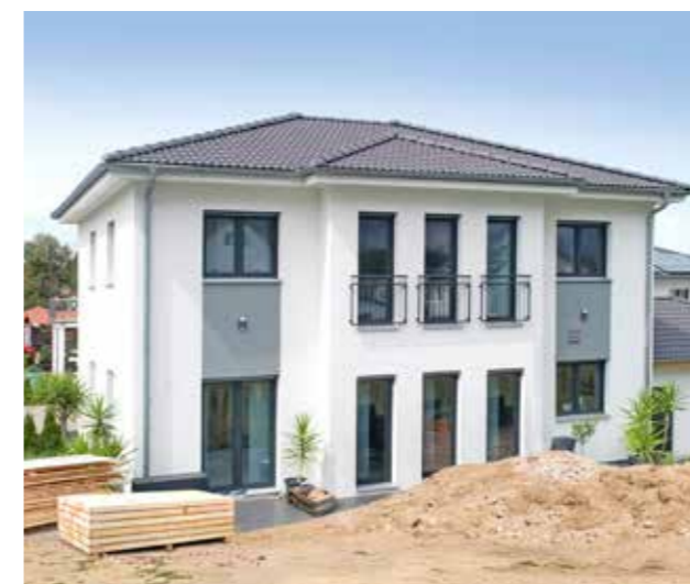
Nach ca. 12 Wochen ist die Villa fertig...
