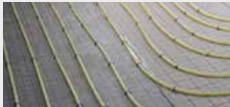
Fußbodenheizung
