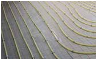
Fußbodenheizung
