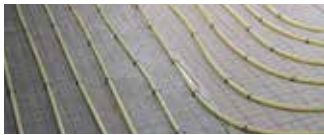
Fußbodenheizung
