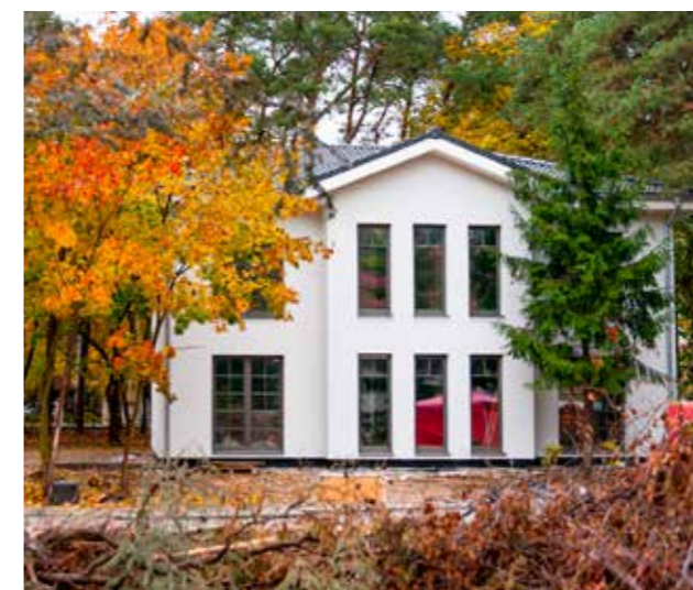
Nach ca. 12 Wochen ist die Villa fertig...
