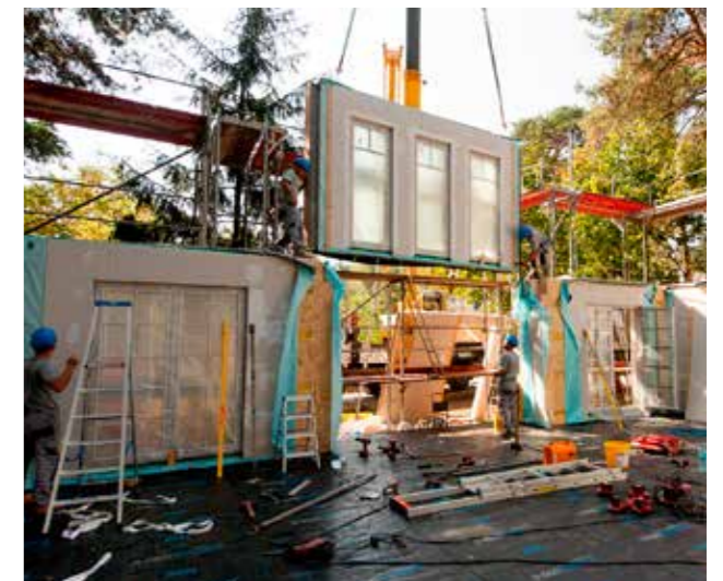
Anschließend wird das Obergeschoss aufgesetzt.
